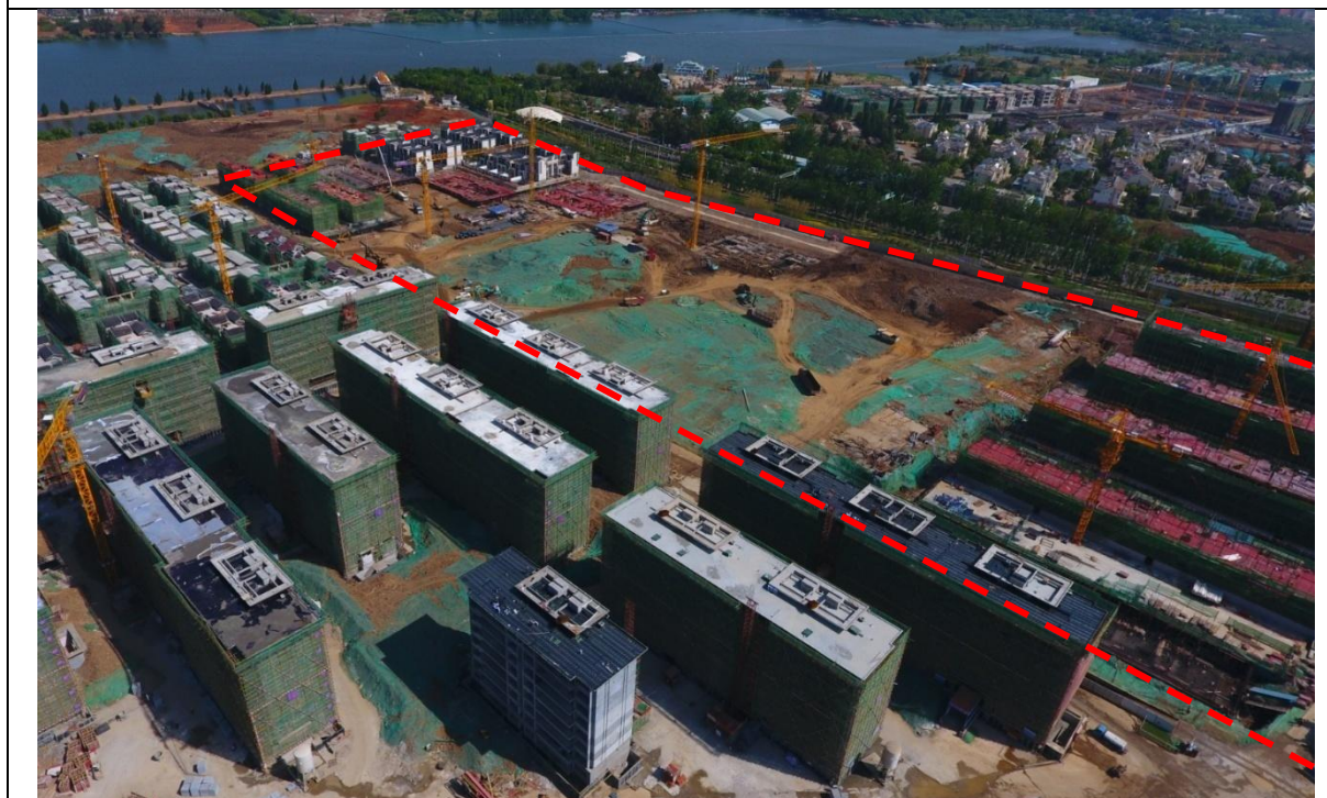
建设过程中总体情况
