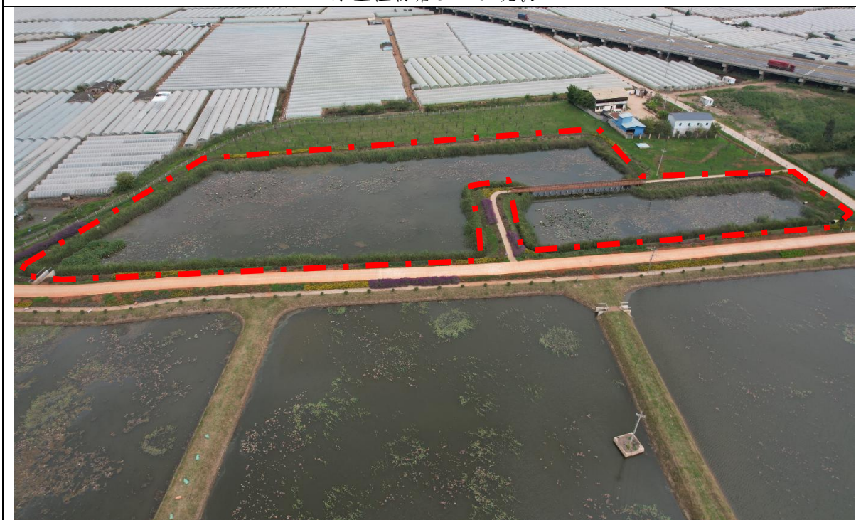
水生植物塘 8#现状
