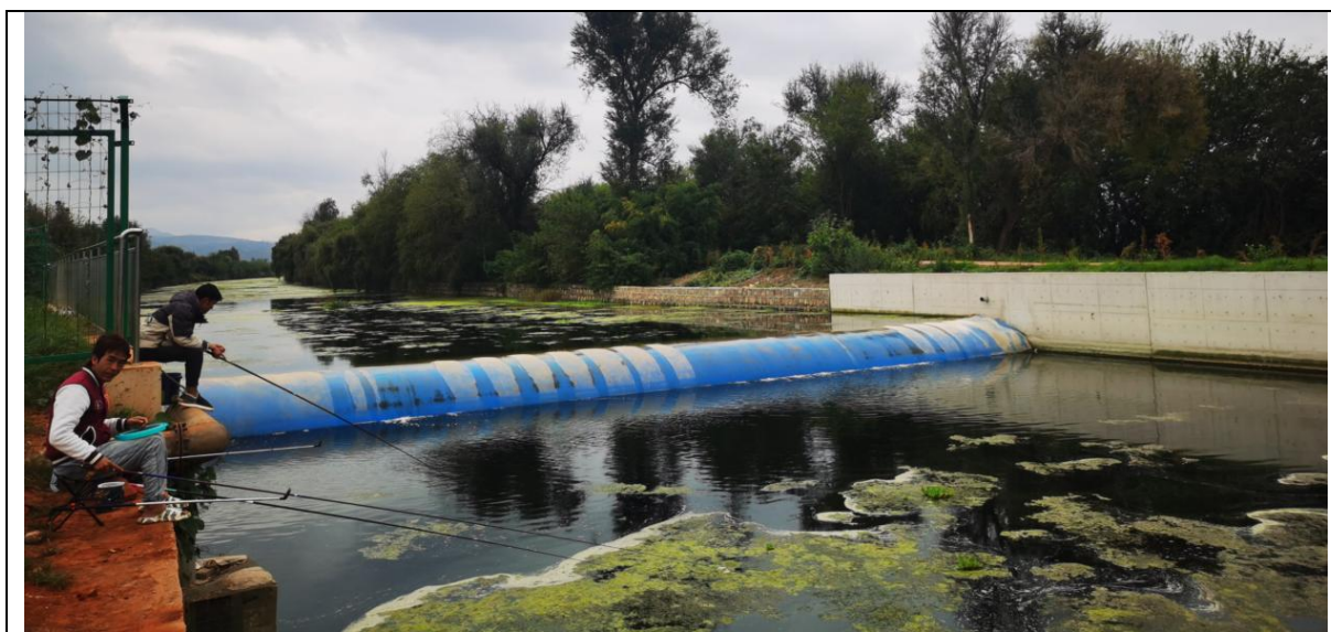
橡胶坝工程区现状
