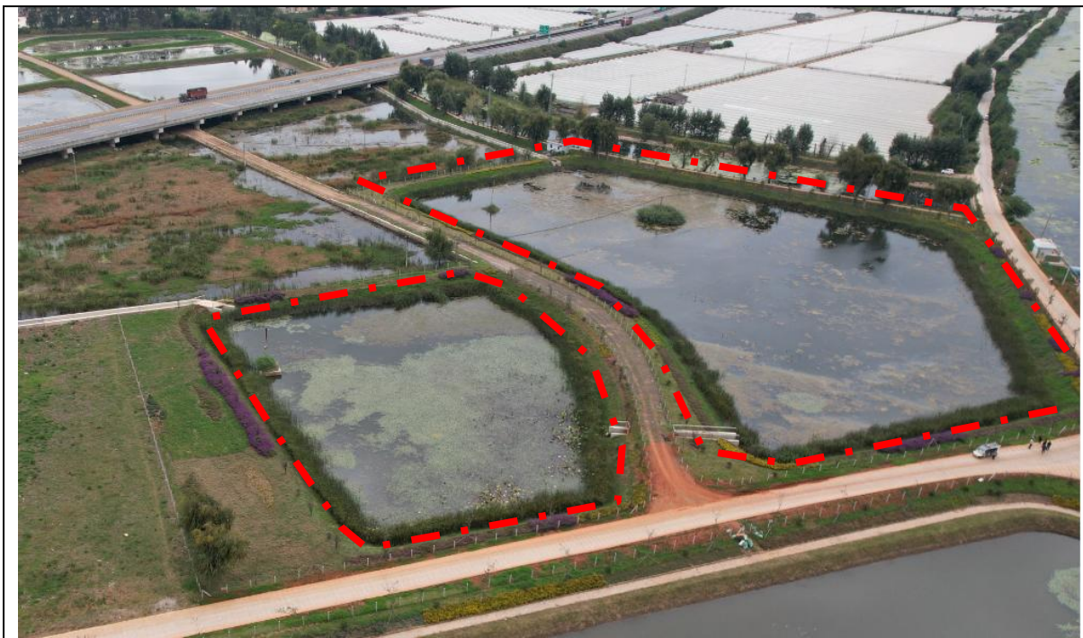
水生植物塘 5#、6#现状
